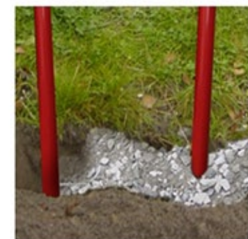
Giet vervolgens het gat vol met beton/cement.
