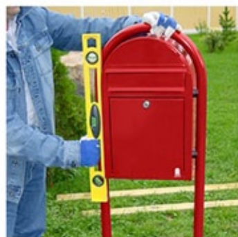
Plaats de brievenbus in het gat en controleer of hij recht staat...
